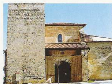
Torre-campanario y fachada principal
