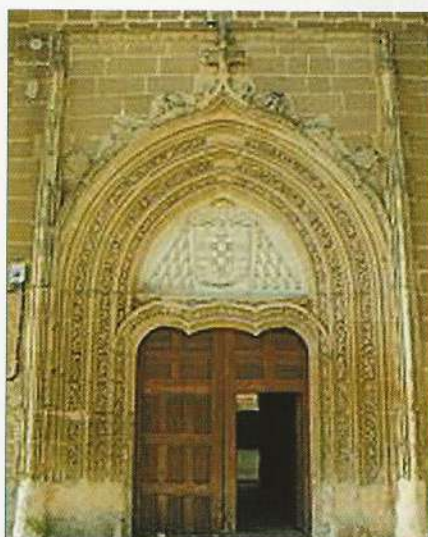
Puerta convento de la Piedad.
