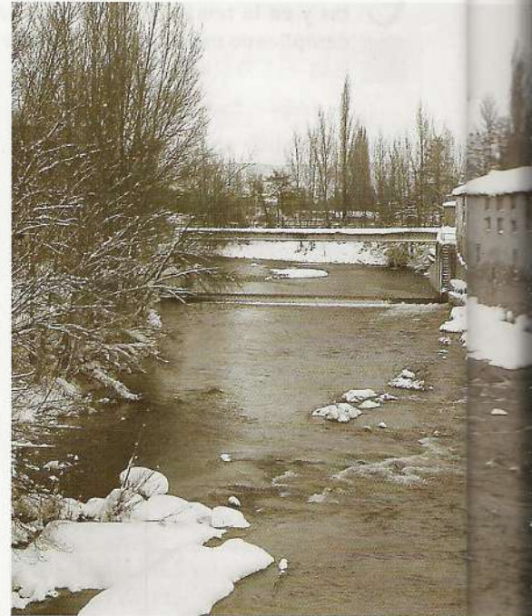
Casas de las tenerías y puente medidor sobre el río Trueba.
