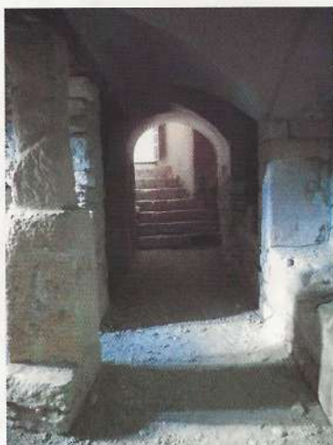
Aspecto interior de la cripta
