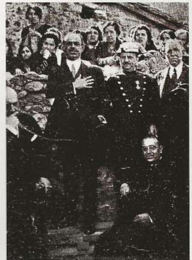
El diputado provincial don Amadeo Rilova pronunciando un discurso en el acto de colocación de la primera piedra para la construcción del depósito de agua.
