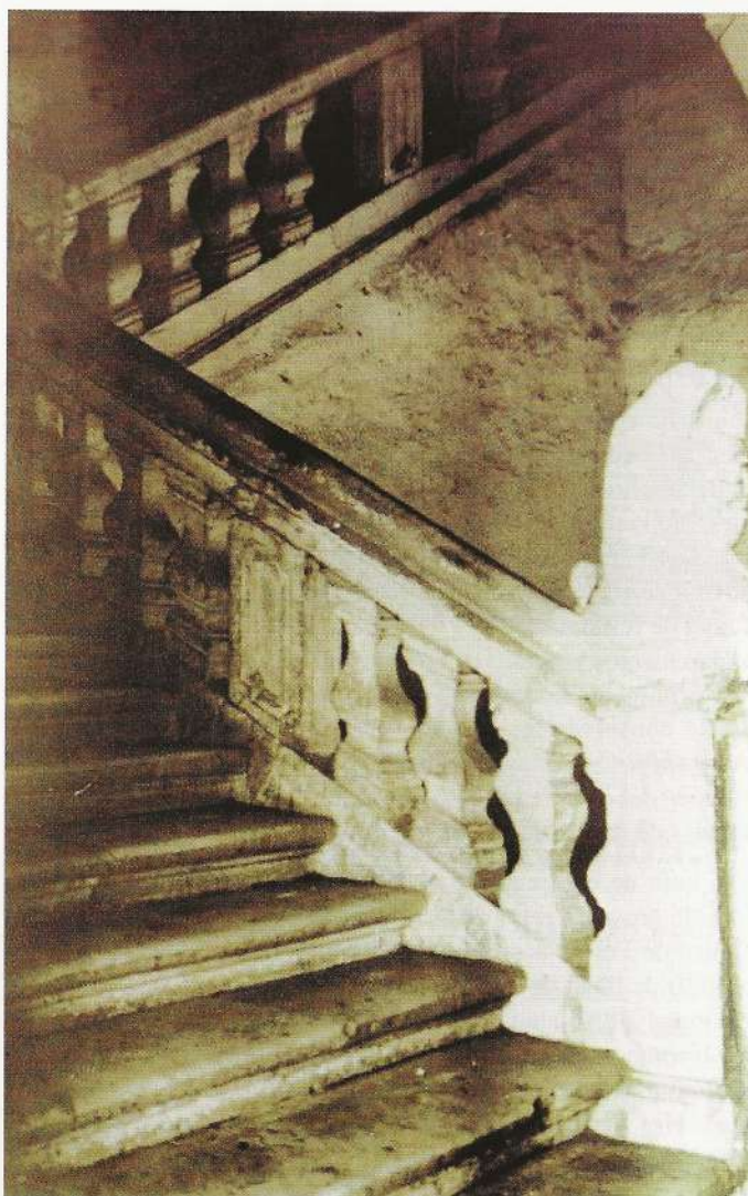
Majestuosa escalera del Hospital de la Vera Cruz. Así se conservaba en 1930.
